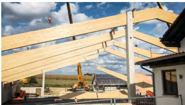
Die Ahamer Halle im Bau und ...
